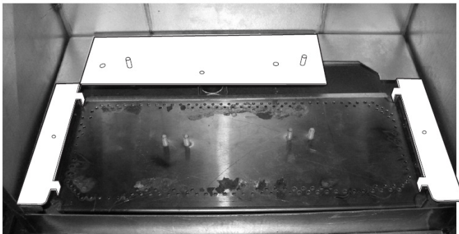
Figure 12. Position des plaques d'extension de la jupe du brûleur après avoir retiré la bordure déflectrice (sans terminaison tuba/Snorkel).
