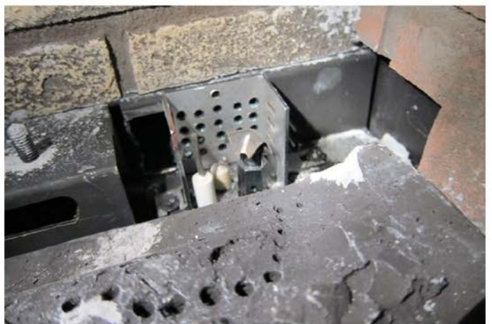
Figure 47. Placez les bûches avec soin pour maintenir dégagé tout orifice de sortie de flamme de la veilleuse.
