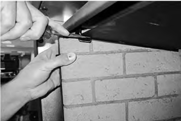
Figure 23. Rabattre les languettes de fixation.
