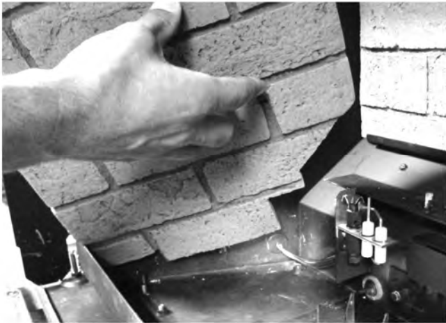
Figure 22. Installer les panneaux latéraux.
