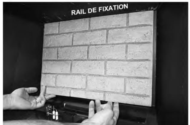
Figure 20. Installer le panneau arrière...
