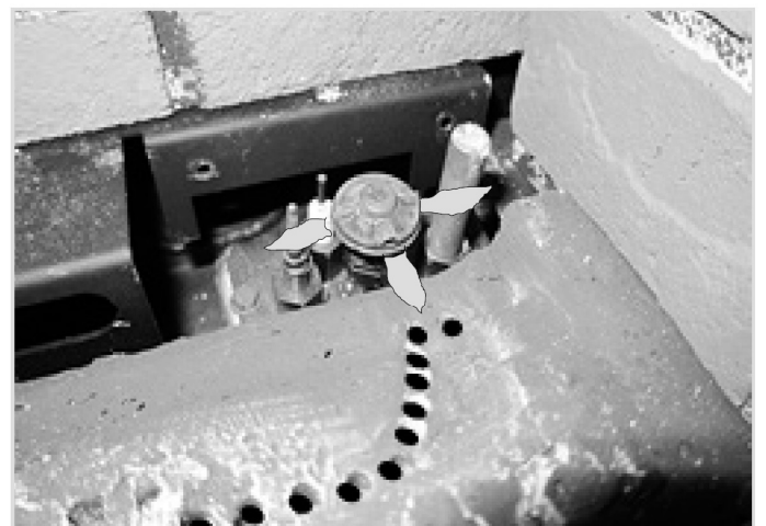
Figure 48. Placez les bûches avec soin pour maintenir dégagé tout orifice de sortie de flamme de la veilleuse.
